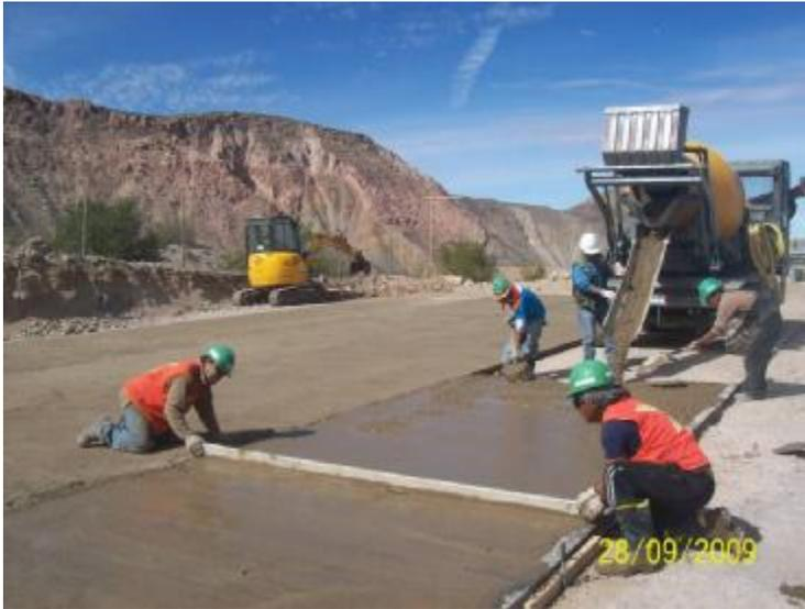
El proyecto Lluscuma, consiste en la construcción de un estanque acumulador de 2.970 m<sup>3</sup> de capacidad, en hormigón armado, cuyas dimensiones son 30\*30\*3,3 m (largo, ancho, alto promedio). Revestir una acequia artesanal existente (de tierra) para transformarlo en un canal de 1.280 metros lineales, con sus paramentos en albañilería de piedra (mampostería) de 0,15 m. de espesor y radier de hormigón de 0,10 m. de espesor, sección 0,50 x 0,35 m, Beneficiando a 56 pequeños agricultores.
