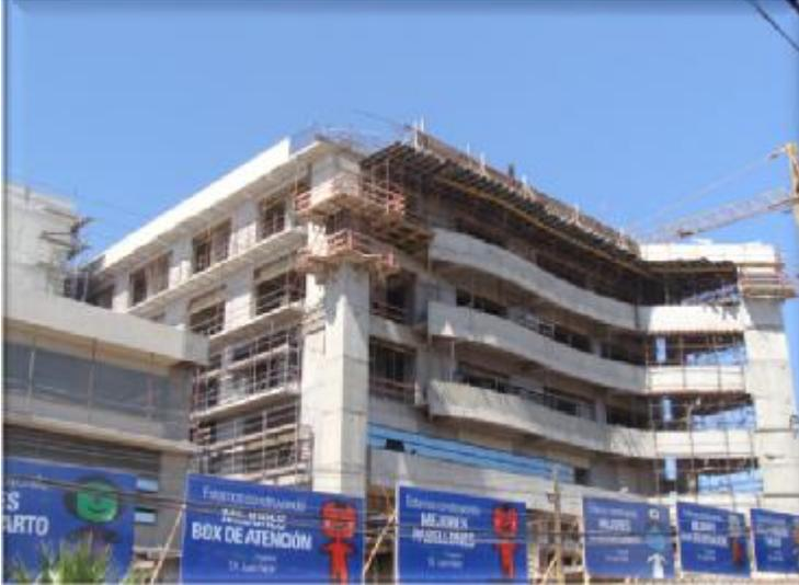
El proyecto consiste en la construcción y remodelación del complejo de edificios que conforma el Hospital, con un total de 41 mil metros cuadrados de obras civiles aproximadamente. El 70 por ciento de esa superficie corresponderá a nueva infraestructura, en específico, a una placa técnica la cual contendrá en los tres primeros pisos a los servicios de apoyo clínico y diagnóstico, y una torre de tres pisos para la hospitalización de pacientes.
